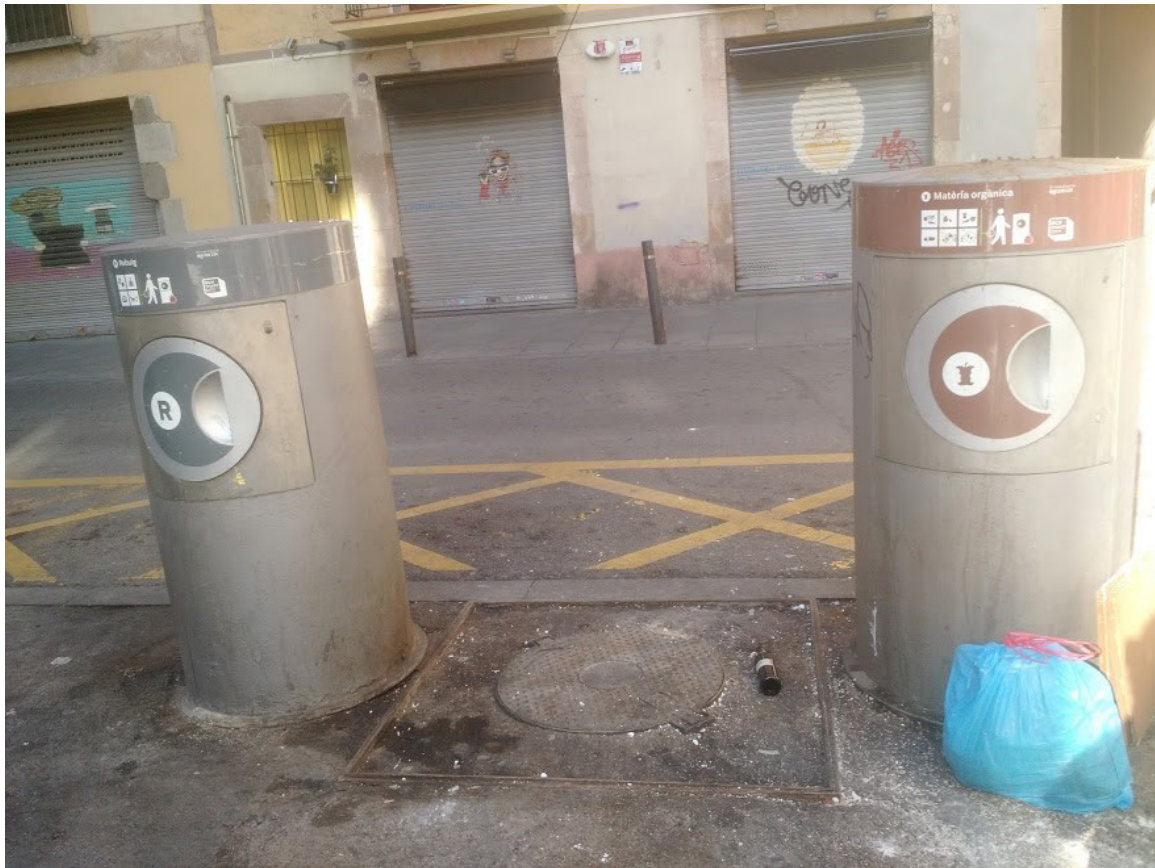
Figura 2: Sistema de Coleta a vácuo em Barcelona-Espanha. Fonte: Arquivo da Pesquisa (2016)
